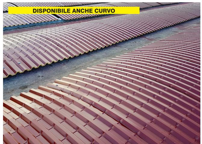
**Isogrek H28** è un pannello monolamiera ottenuto dall'accoppiamento di un resistente profilo metallico h 28 mm ad uno strato di poliuretano ad alta densità schiumato in continuo. Modulare, leggero, isolato e resistente, si adatta ad ogni tipo di impiego per il tamponamento dell'involucro esterno dell'edificio.
